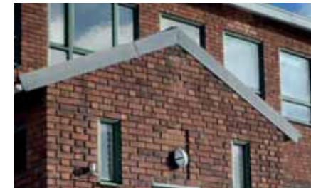
Wedholms kontorsbyggnads fönster och indragna fogar beaktas.
