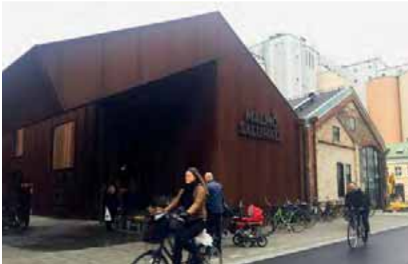
Referens: Tillbyggnad i corten mot befintlig tegelbyggnad. Malmö Saluhall, Malmö.
