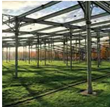
Park med friställd byggnadsstomme. Hermann Blankenstein park, Berlin. Befintlig stomme på bebyggelse inom Wedholms kan sparas och bli spännande inslag på skolgård.
