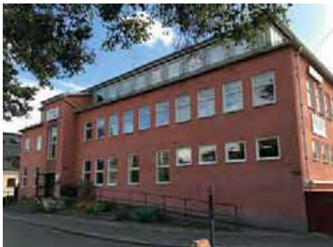
Omvandling verksamhetsbebyggelse. Nyköping
