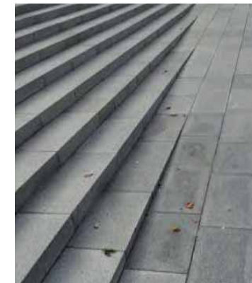
Bred trappa som går in i ramp
