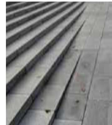
Bred trappa som går in i ramp
