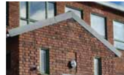
Wedholms kontorsbyggnads fönster och indragna fogar beaktas.
