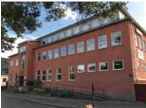
Omvandling verksamhetsbebyggelse. Nyköping
