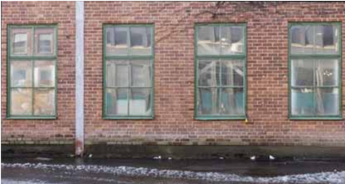
Figur 8-5: Maskinverkstadens östra fasad med ursprungliga spröjsade träfönster. Foto: Mariette Svensson 2017.
