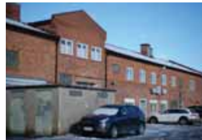
Försvunna kvalitéer får möjlighet att återskapas.
