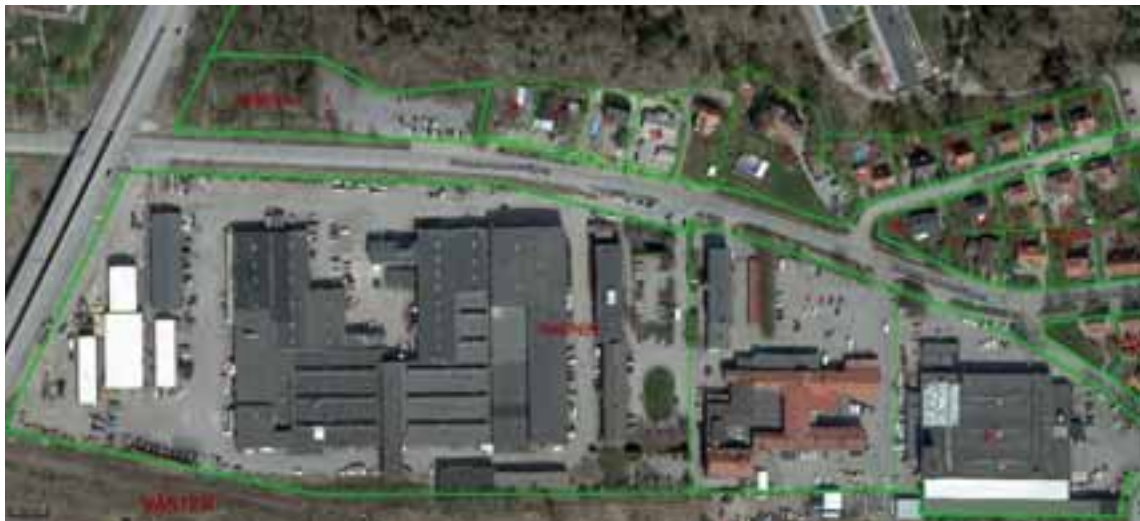
Figur 3-2: Ingående fastigheter, Raspen 1, 2 och 3.
