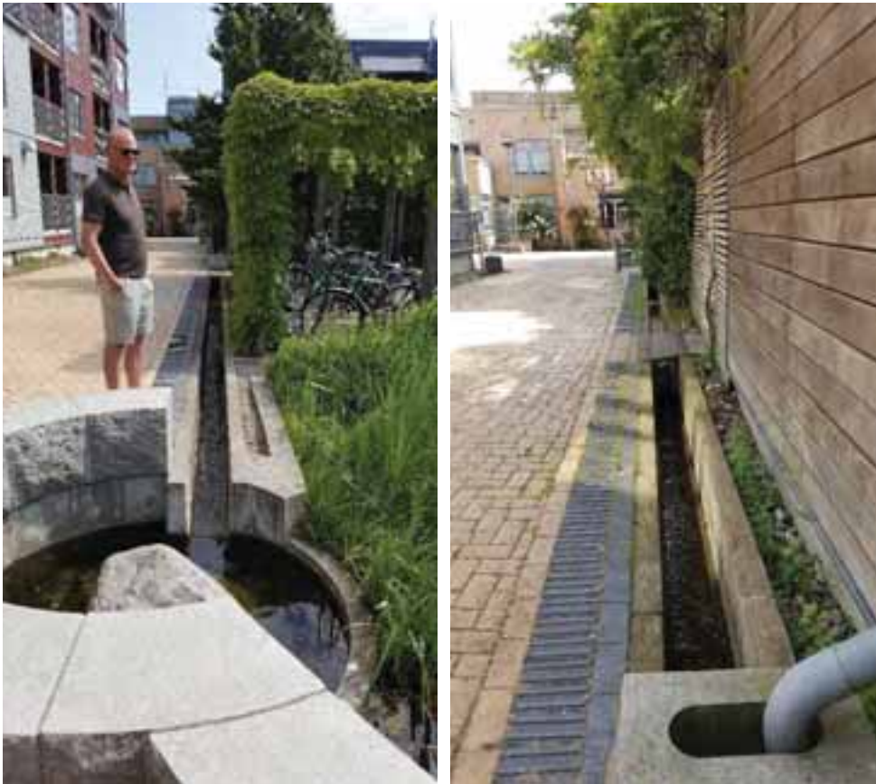
Figur 8-32: Visar utloppet från växtbädden och hur dagvattnet leds vidare förbi huskropparna och tar emot dagvatten på vägen. Vattnet rinner sedan ut i ytterligare växtbäddar och multifunktionella ytor. Foto: Structor
