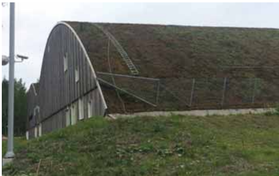
Figur 12. Grönt sedumtak på SEB USIF arena, Uppsala. Foto: E. Hagström, Structor Uppsala AB (2016).
