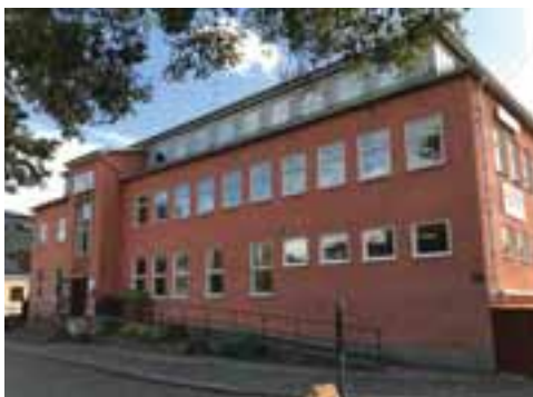
Omvandling verksamhetsbebyggelse. Nyköping
