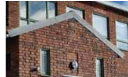
Wedholms kontorsbyggnads fönster och indragna fogar beaktas.
