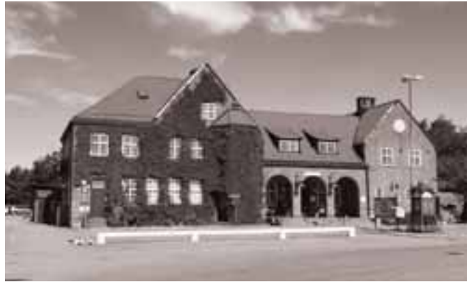
Befintlig stationsbyggnad söder om järnvägen
