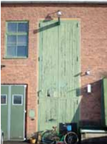
Wedholms västra fasad
