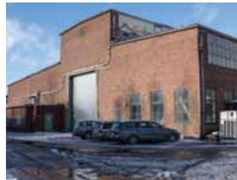
Wedholms maskinverkstad bevaras och omvandlas till skola/förskola. Väster om byggnaden kan stomkonstruktion friställas och bli ett skulpturalt inslag i planerad förskolegård (likt Hermann Blankensteins park i Berlin)
