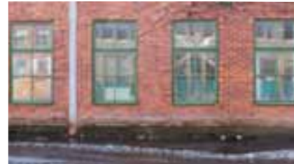
Maskinhallens spröjsade fönster bevaras.
