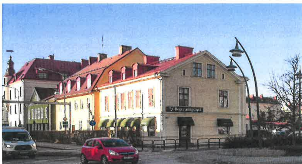
Bilden visar de historiskt värdefulla byggnaderna på Repslageragatans norra sida. De två närmast i bild ligger inom Rättstjänaren 9. Husen är uppförda 1885 och 1919.
