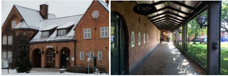
Befintligt stationshus sett från Centralplan samt loggia på stationens västra sida.
