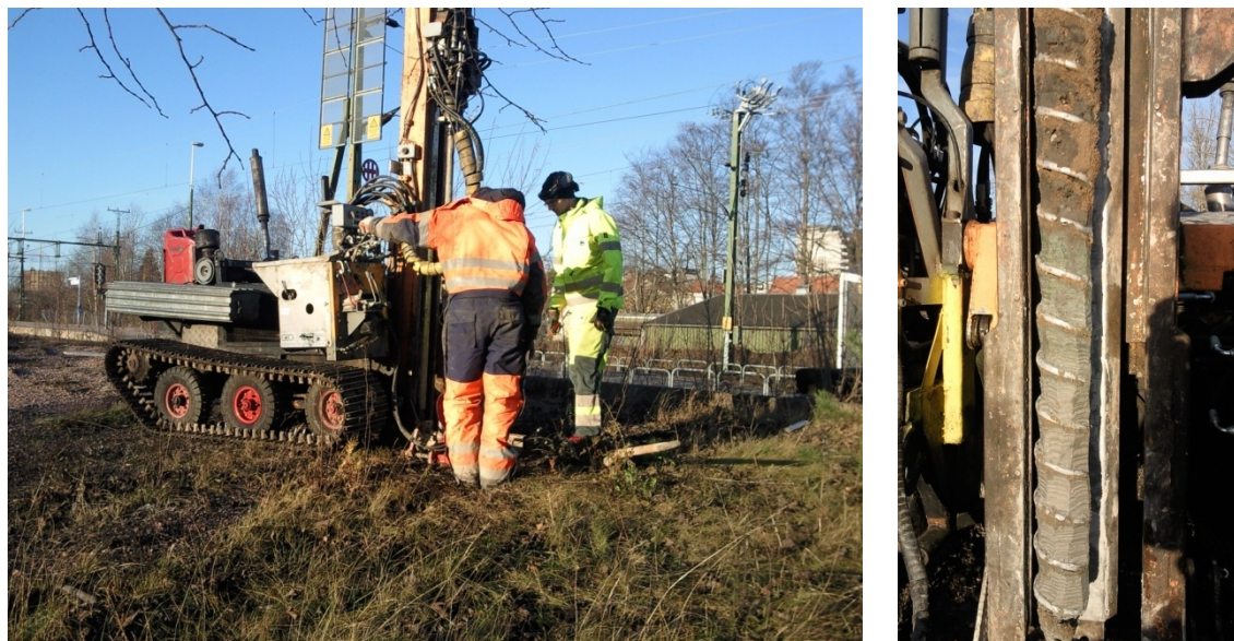
Figur 1. Undersökningsborrning med borrhandsvagn vid punkt 105. I figuren till höger ses en ca 1 m lång jordprofil vid övergången mellan fyllningsjord och varvig siltjord i samma punkt.
