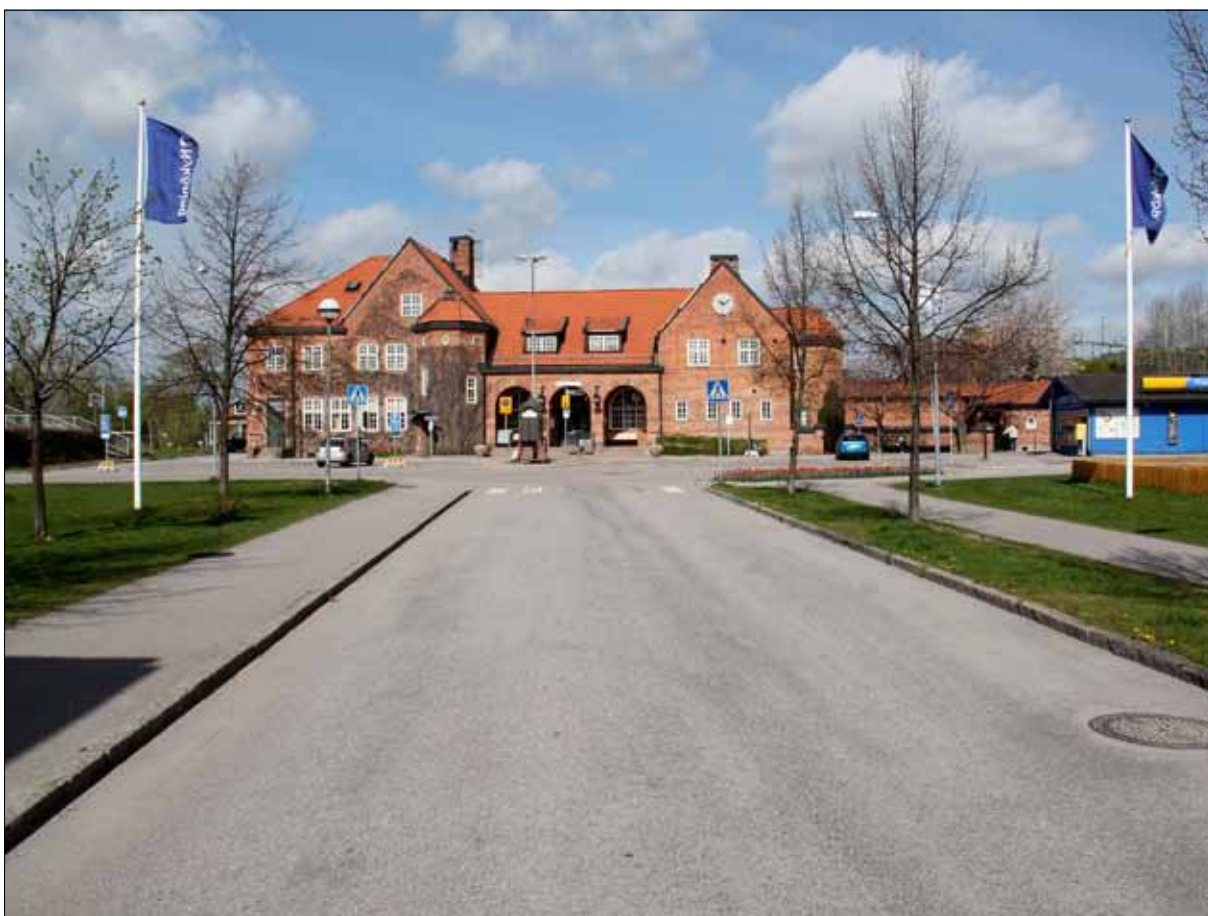
28 Nyköpings stationshus fungerar som fondbyggnad där Järnvägsgatan, Borgaregatan och Södra Bangårdsgatan sammanstrålar på Centralplan i en mjuk bågform framför stationshusets entréloggja (Slm D12-0442).
