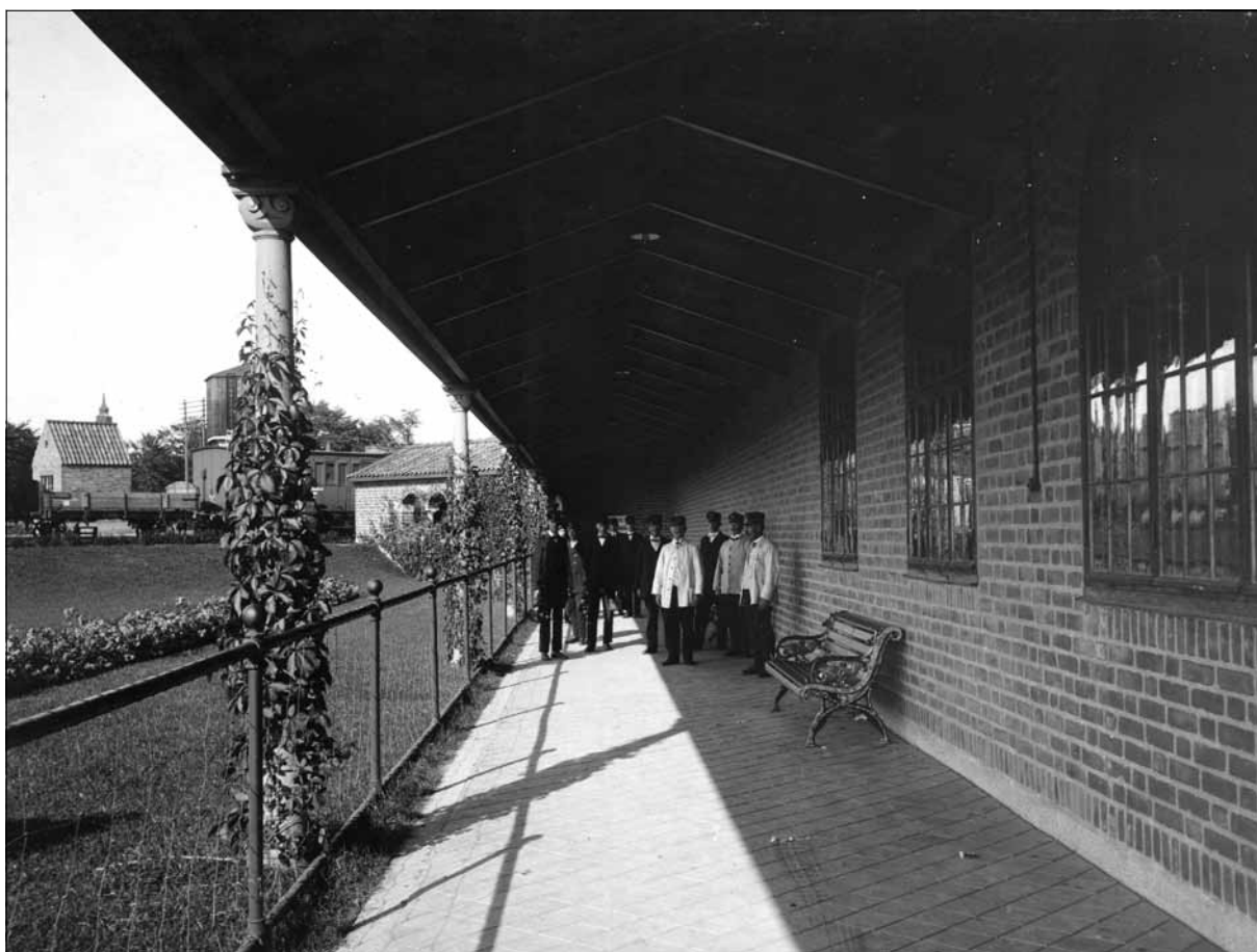
14 Loggian utefter stationshusets fasad mot spårområdet löper mellan vestibulen och nedgången till gångtunneln under spårområdet. Fotografiet är taget år 1916 av Axel Eliasson, Stockholm (Slm M029382).
