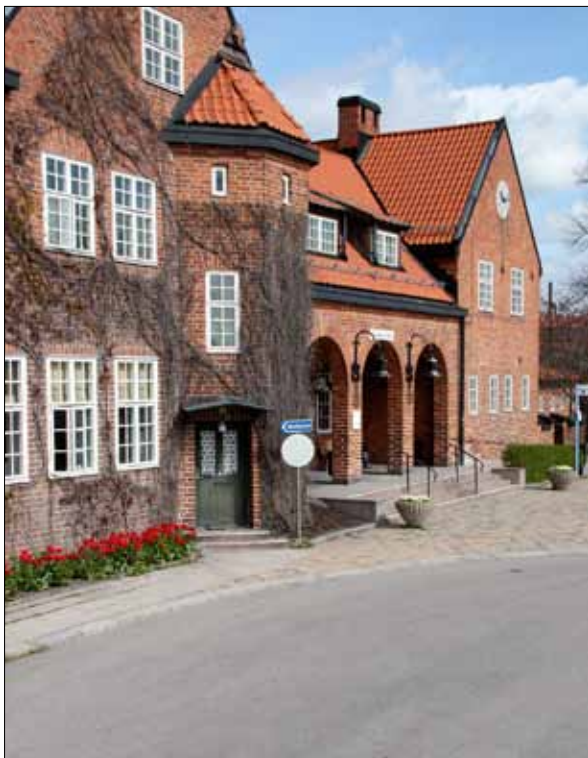
26 Stationshusets gårdsfasad mot Centralplan och staden (Slm D12-0440).
