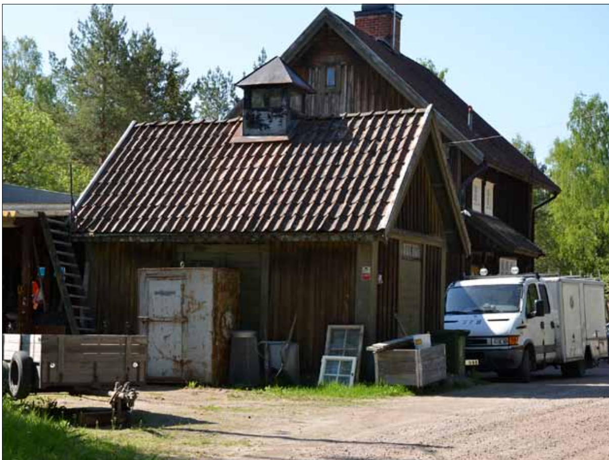
59 Stationshuset i Svärtagård, numera privatägt. Stationens exteriör har samma nationalromantiska arkitektur som Nyköping (Slm D12-0470).
