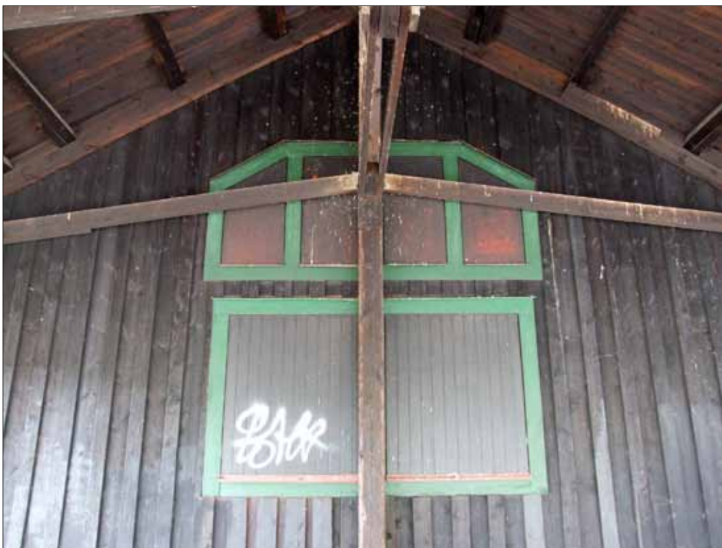
41 Övre delen av godsmagasinet västra gavel. Det övre fönstret är troligen den ursprungliga fönsteröppningen som flyttades med vid utbyggnaden. Foto: Eva Wockatz, Sörmlands museum (Slm D12-0452).
