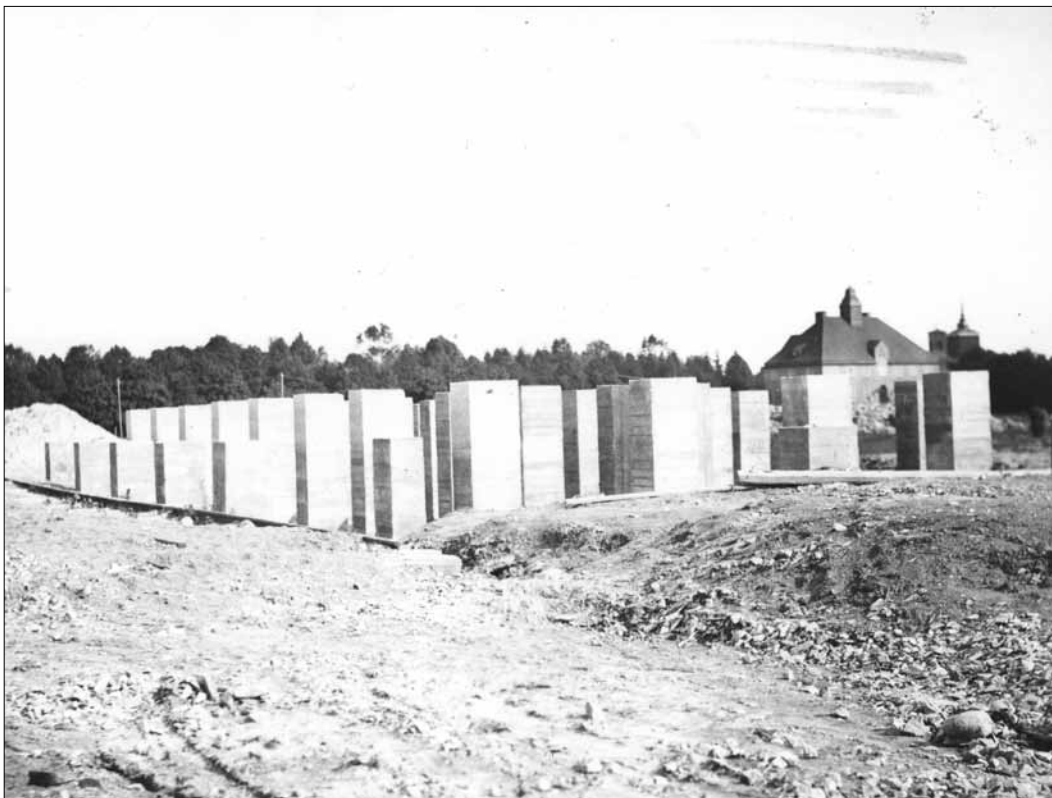
15 Betongpelarna till det första godsmagasinet som göts 1912. I bakgrunden syns tingshuset och västra klockstapeln. Foto: Gustaf Samuelsson (Slm X4236-78).
