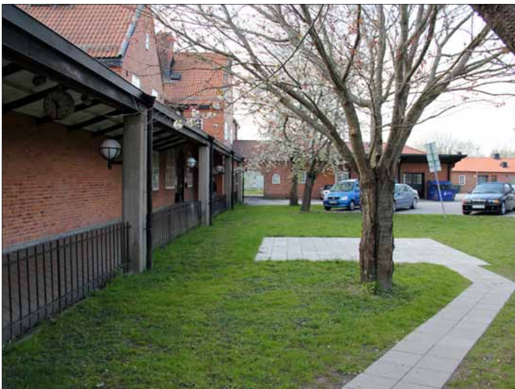
58 I ett nationellt perspektiv förefaller Nyköpingslösningen på fasaden mot spårområdet med en lång loggia, som leder till gångtunneln under spårområdet vara relativt unik (Slm D12-0469).
