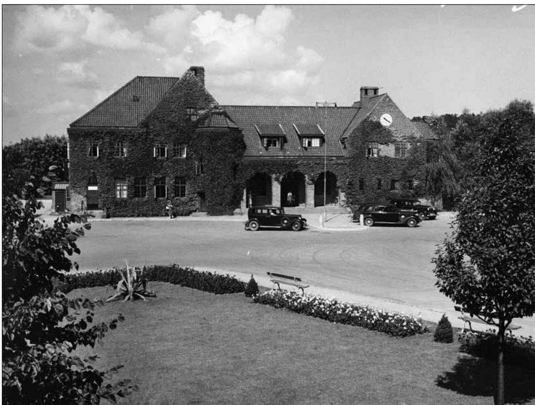
10 Fotografiet, som är taget på 1940-talet, visar att ett trottoarparti har anlagts närmast stations-trappan, sannolikt för att ordna upp biltrafiken vid av- och pålastning (Nyköpings kommun DIB199).
