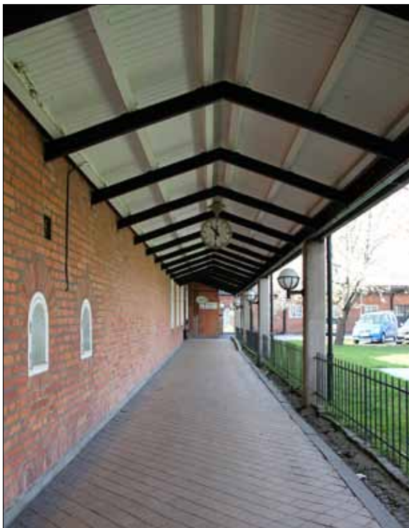
30 Loggian mot spårområdet på stationens västra sida är välbevarad (Slm D12-0443).
