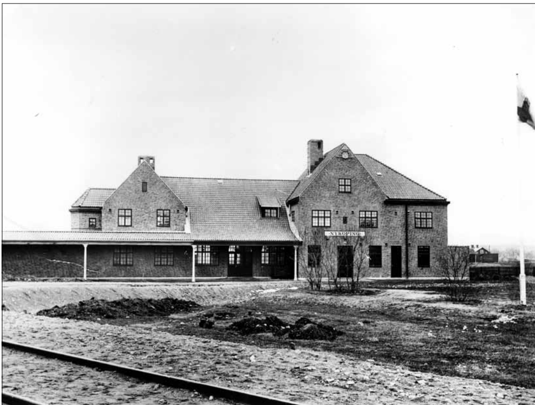
13 Stationshuset fasad mot spårområdet strax efter uppförandet. Fotografiet är taget mellan 1913 och 1915 (Jvm KDAA07031).
