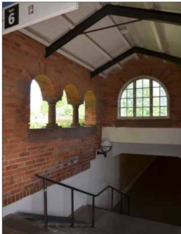
31 Trappan till gångtunneln under spårområdet tillkom då stationshuset uppfördes på 1910-talet (Slm D12-0444).
