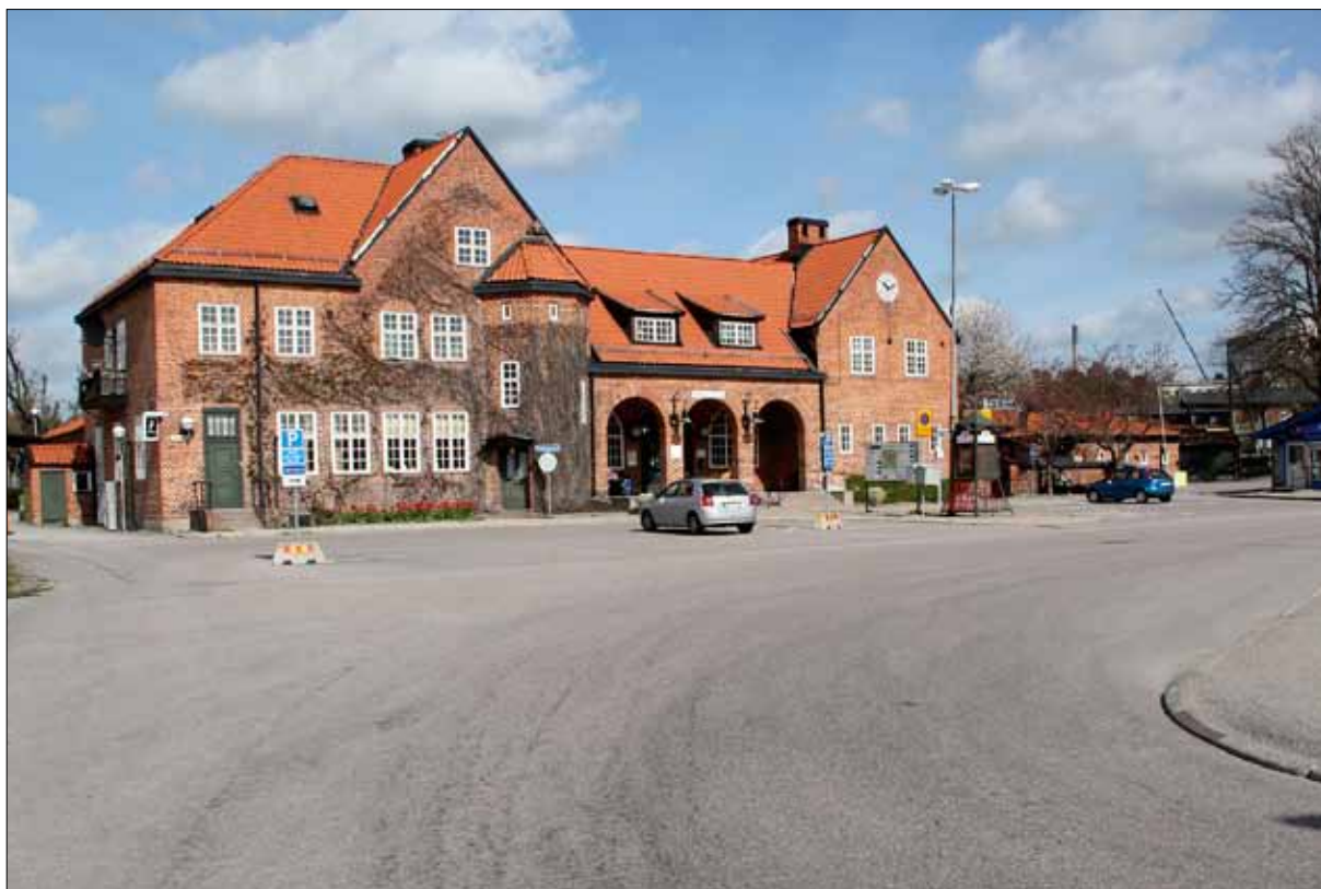
63 Centralplan och Nyköpings stationshus (Slm D12-0473).
