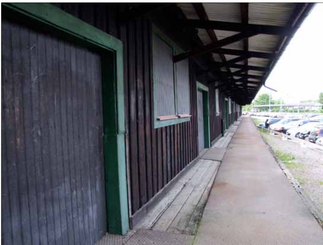
42 Godsmagasinsbryggan mot spårområdet. Magasinsbryggan, fasadpanelen och portarnas karmar är nötta och bär spår av all fraktgodshantering. Foto: Eva Wockatz, Sörmlands museum (Slm D12-0453).
