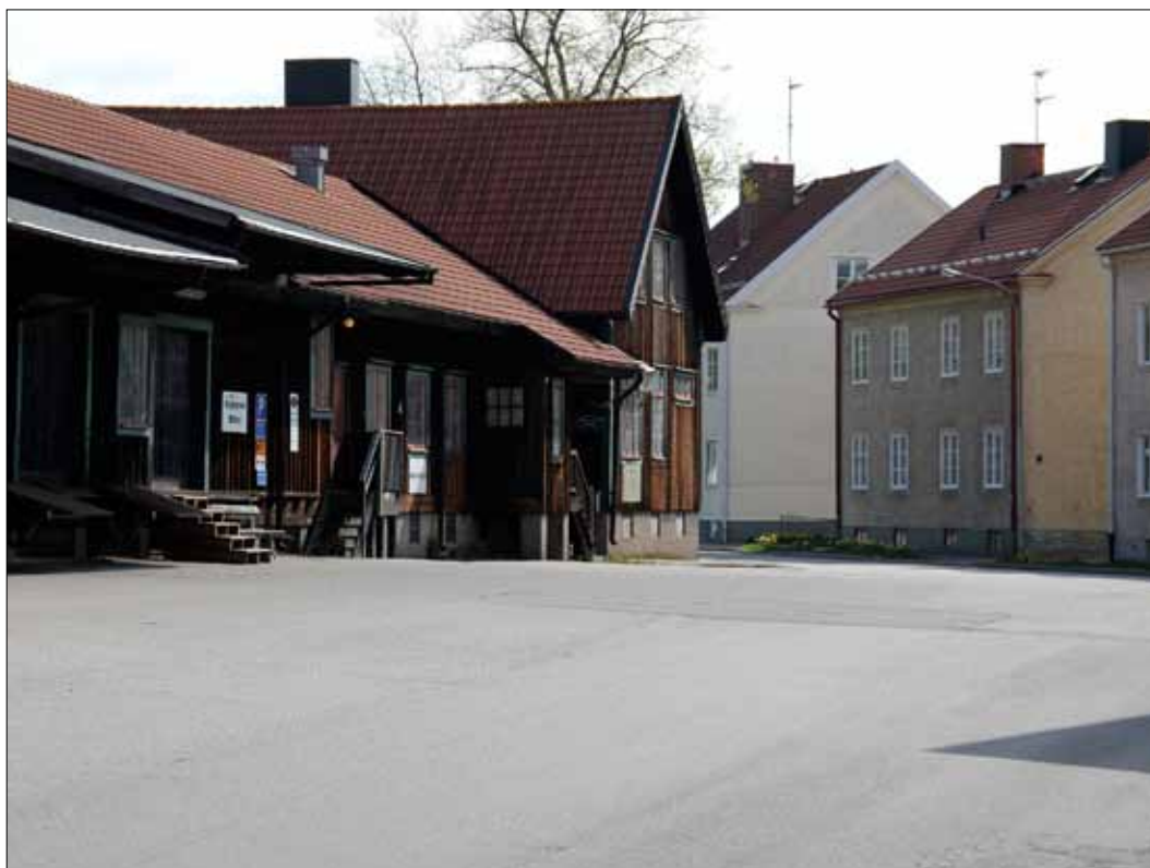
39 Godsmagasinet's sydöstra del, med expeditjonslokalerna sett från Södra Bangårdsgatan (Slm D12-0450).
