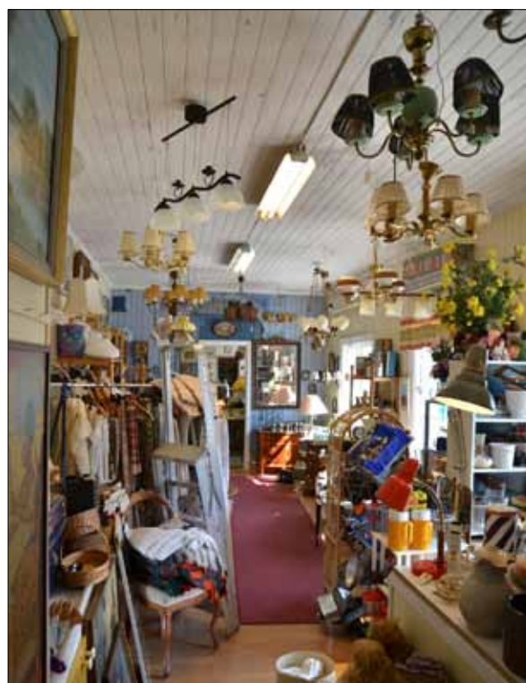
44 Vy av godsmagasinet östra del, som nu hyrs ut till en antikhandlare. Väggar och tak är klädda med pärlspontpanel (Slm D12-0455).
