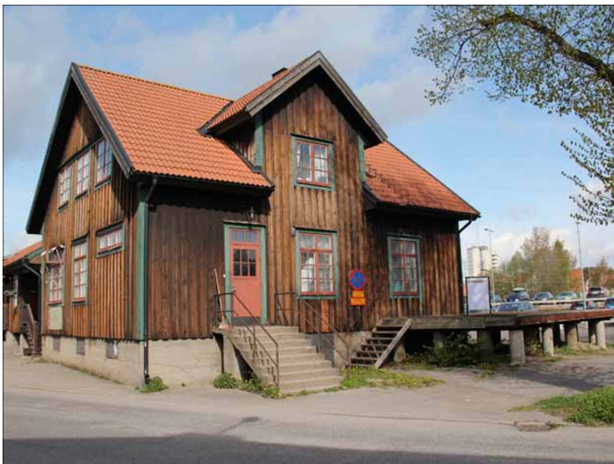
40 Godsmagasinet östra del byggdes 1918. Här låg expeditiionslokalerna. På övervåningen fanns övernattningsrum för sovvagnskonduktörerna, idag bostadslägenheter (Slm D12-0451).
