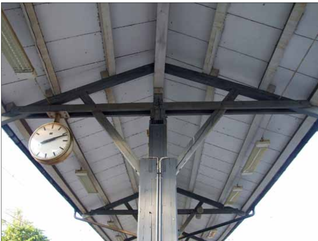
54 Plattformstaket sett underifrån. Foto: Eva Wockatz, Sörmlands museum (Slm D12-0465).
