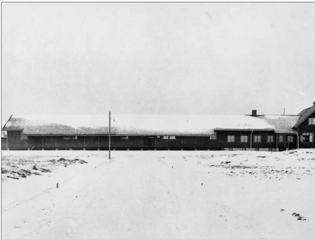
22 Godsmagasinet sett från söder omkring 1919. Fotografiet är inlänat från SJ. Foto Elin Lagerstam, Nyköping (Jvm).
