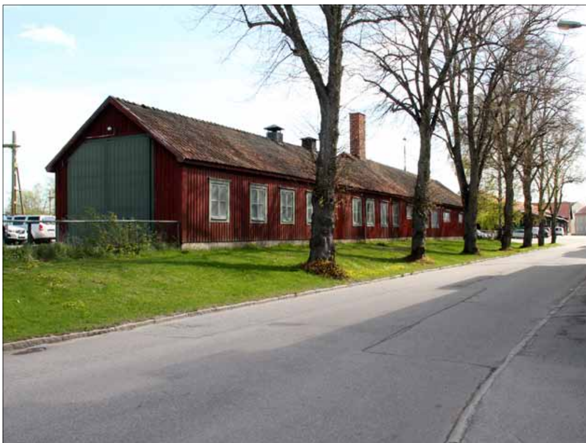
48 Förrådshus och lokomotorstall sett från stationen och sydväst. Tidigare fanns det spår in i västra gaveln, som växelloket kördes in på (Slm D12-0459).
