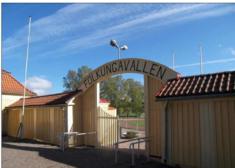
Figur 5. Folkungavallen är en idrottsplats från tidigt 1900-tal med flera arkitekturhistoriskt intressanta byggnader i nationalromantisk anda. Järnvägen går kant i kant med idrottsplatsens södra långsida. Foto: Lars Norberg 2014, Sörmlands museum.
