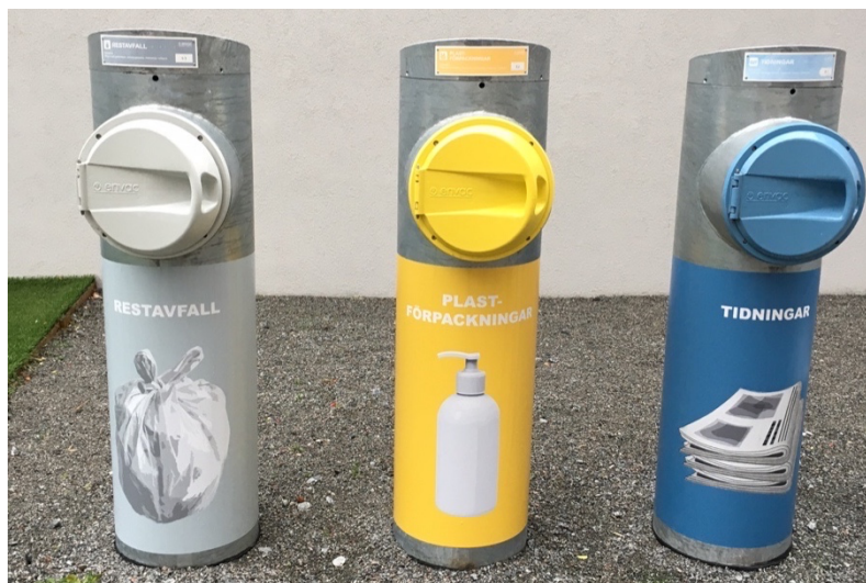
Figur 10 Inkast i sopsugssystem för flera fraktioner, exempel från Barkarbystaden i Järfälla kommun. Foto: Järfälla kommun
