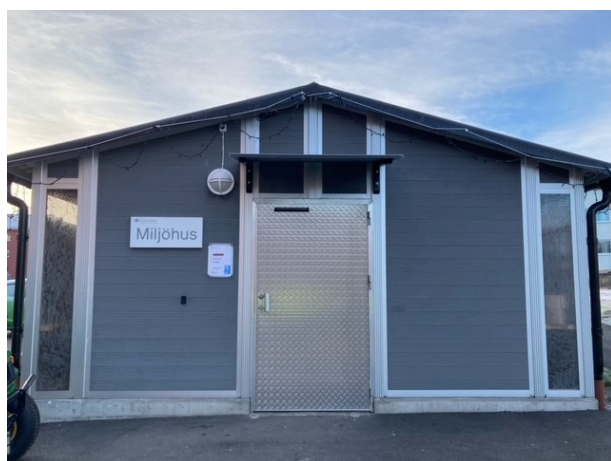
Figur 9 Miljöhus för mat- och restavfall, förpackningar och returpapper. Exempel från lägenhetsområde i Oxelösund. Foto: Oxelö Energi AB
