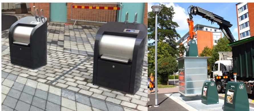
Figur 8 Inkast till underjordsbehållare (t.v.). Tömning av underjordsbehållare (t.h.). Foto: PWS AB (t.v.), San-Sac AB (t.h.)
