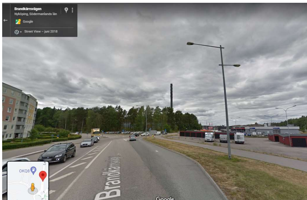
Bild över befintlig vägstruktur, korsningen Brandkärrsvägen/ Gustavsbergstigen samt de garage som omfattas av rivning. Bild från Google.
