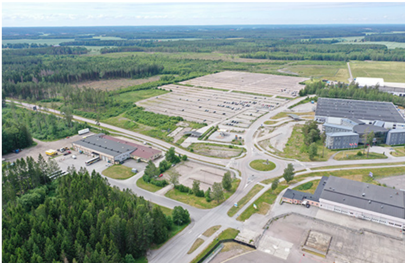
Vy i sydvästlig riktning över stora delar av utvecklingsområdet. Till vänster i nedre delen av bilden syns Sydöstra området. Till höger i nedre delen av bilden syns delar av flygplatsen. Vid cirkulationsplatsen möts väg 628 (General Schybergs väg) och 629. På bilden syns även stora markparkeringsplatser tillhörande flygplatsen. Parkeringsytorna befinner sig i det Södra området.
