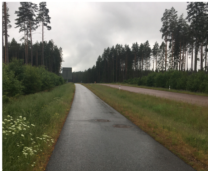
Gång- och cykelväg vid väg 629.
