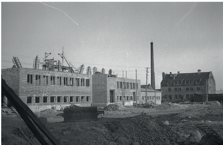
Slakteriets charkuterifabrik från 1917 till höger. Till vänster byggs slakteriets kontors- och bostadshus.
