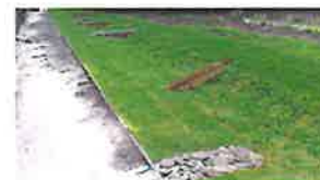
Exempel på ekologisk dagvattenhantering med fördröjning och rening av dagvatten genom grönytor.
