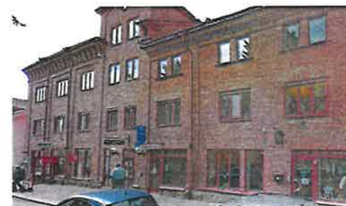
Sockelvåning med skyltfönster (Västra Trädgårdsgatan)
