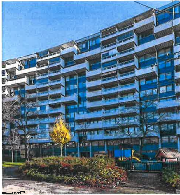
variation och assymetri i balkonglinjer och inslag av glas i fronter, förhöjd sockelväning (Grindtorp, Täby)
