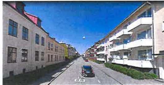
Utanpåliggande balkonger på nyare byggnader (Bagaregatan)
