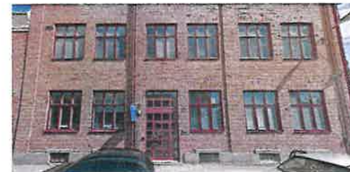
Stor skala: Naturstenssockel med indrag av tegelfält (Hospitalsgatan)
