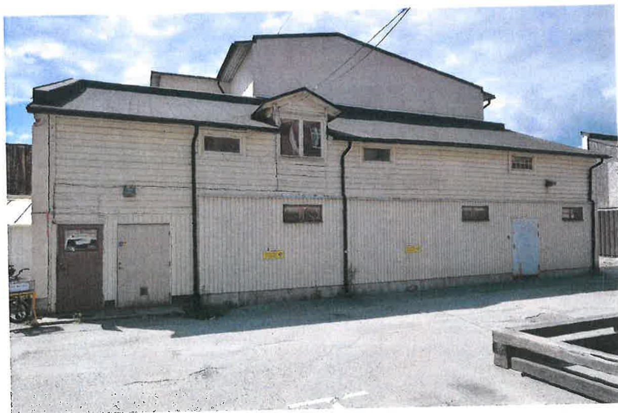
Västra längan. Bottenvåningen upptas nästan i sin helhet av ett soprum tillhörande Indiska. Denna del har tilläggsisolerats och försetts med ny panel. Bakom dörren längst till vänster leder en trappa upp till övervåningen där det finns ett inrett utrymme vid takkupan. (SLM D2018-0599)
