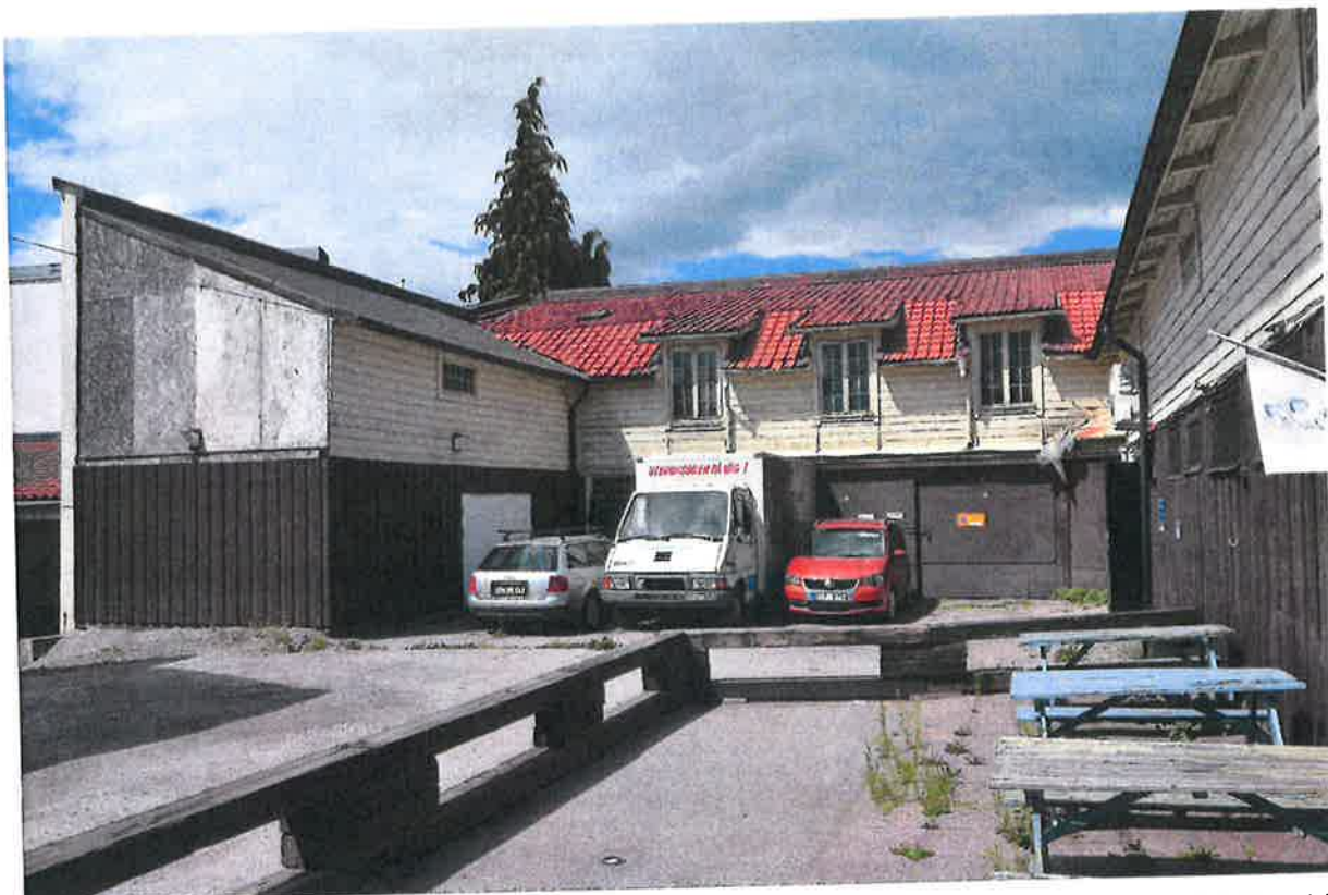
Den kvarvarande delen av västra längan och den norra med de tre takkuporna. Till vänster syns infarten som skapades när en del av västra längan revs. Snittet har täckts för med spånskivor och panel. (SLM D2018-0597)
