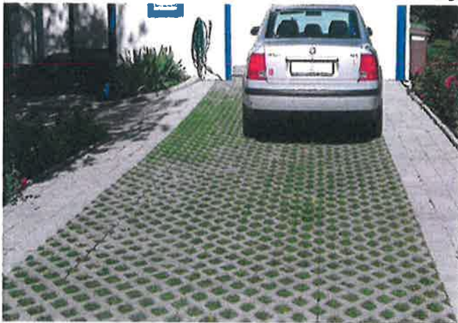
Figur 6 Gräsarmering på garageuppfart. Källa: www.alltimark.se
