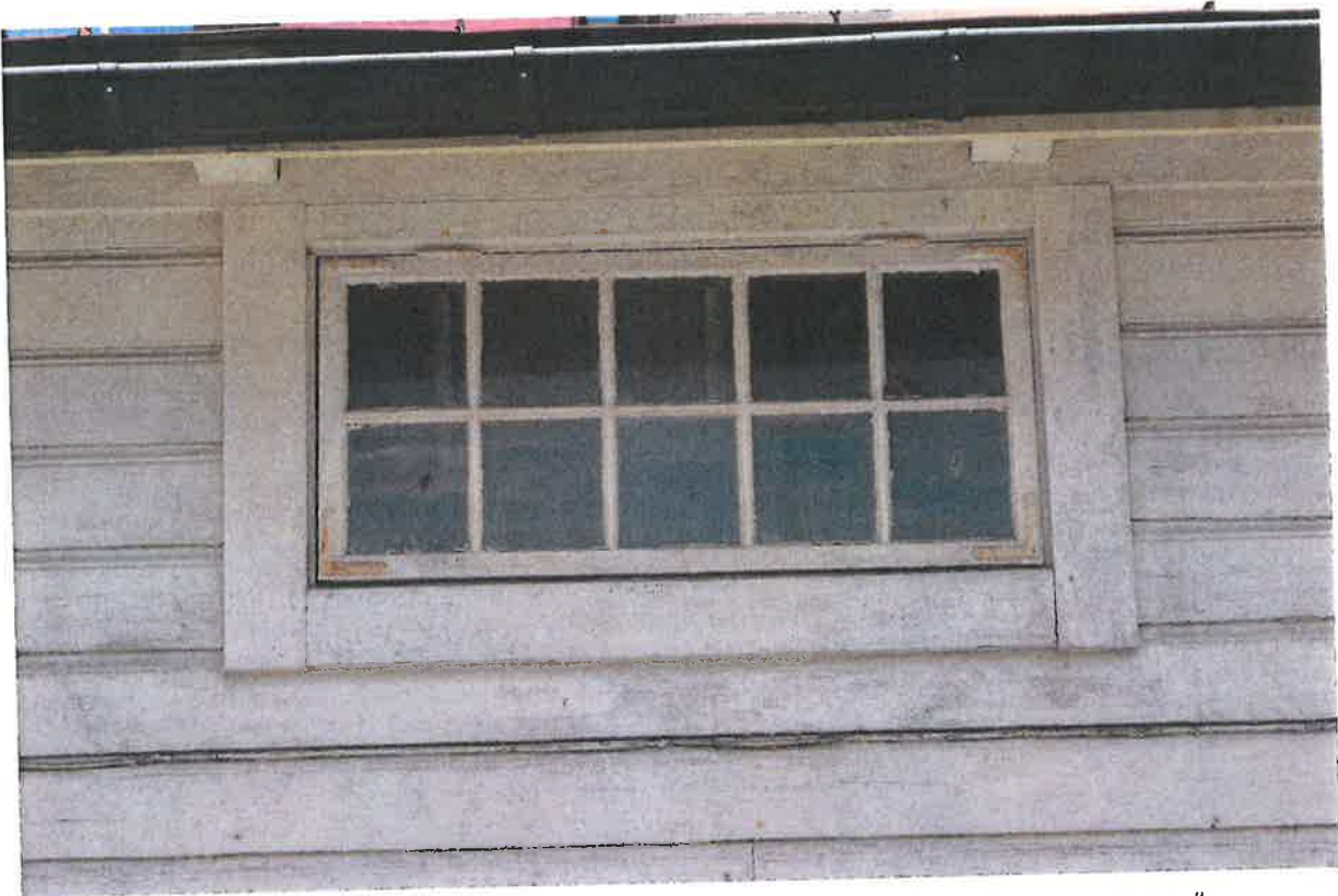
Ett av fönstren under takfoten på den östra längan. Dessa är överlag i gott skick och skulle enkelt kunna renoveras eller kompletteras med energiglas invändigt för att förbättra energiprestandan. (SLM D2018-0602)
