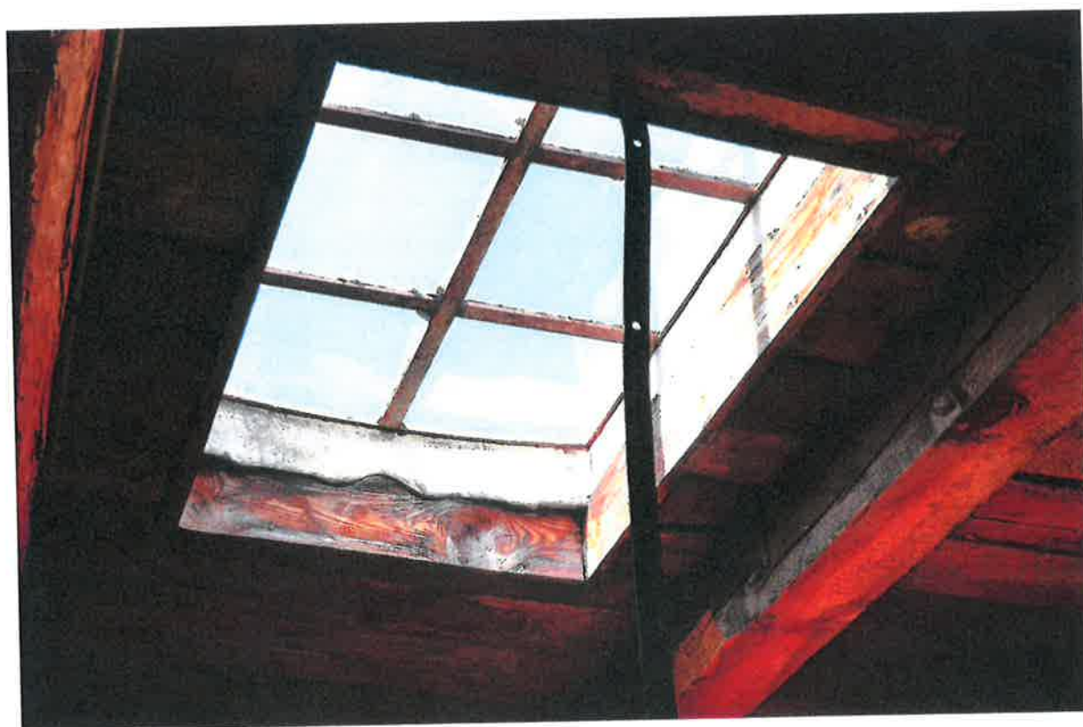
Ett av takfönstren på den norra längan. Spröjsen är av järn. Spröjsning även i takfönstren är viktigt för den ålderdomliga karaktären. (SLM D2018-0614)
