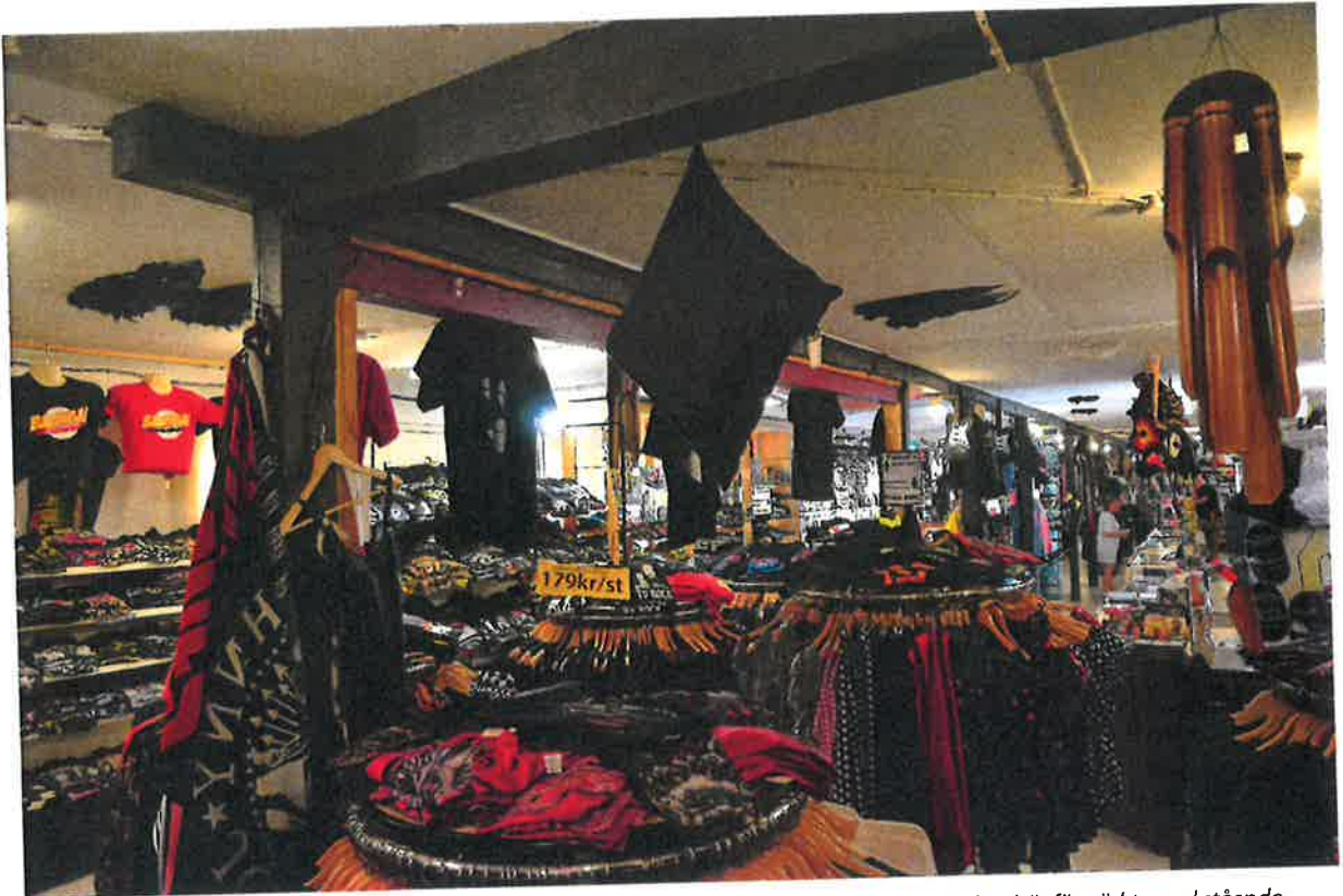
Bild av butiksinteriören i den östra längan sett från norr. Den bärande stommen som är synlig har här förstärkts med stående plank och en liggande I-balk. (SLM D2018-0607)
