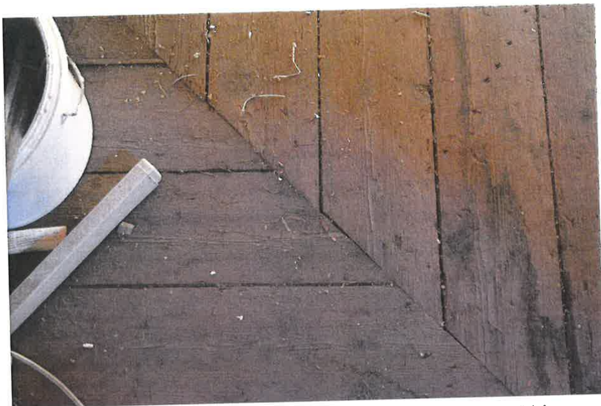
Bräddgolvet som ligger på den övre våningen i östra och norra längan. Golvet skulle i renoverat skick ge ett mervärde åt nya lägenheter. (SLM D2018-0600)
