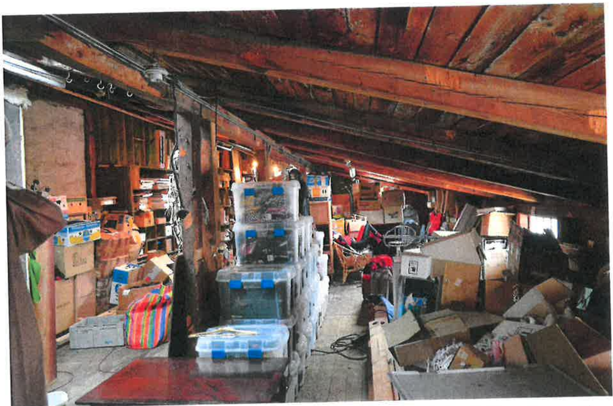
Den östra längans yttre del sett från norr. Till höger skimtar ett av fönstren placerat under takfoten. De bärande stolparna och bjälkarna i taket är viktiga för uthuskaraktären och skulle om de bevarades ge ett mervärde i nya lägenheter. (SLM D2018-0611)
