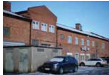
Försvunna kvalitéer får möjlighet att återskapas.
