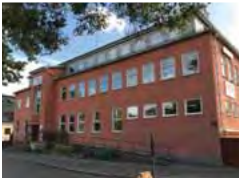
Omvandling verksamhetsbebyggelse. Nyköping
