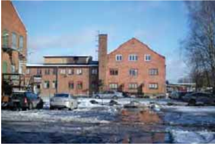
Slakteriets nationalromantiska charkuterifabrik
