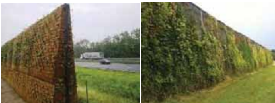
Referensbilder på bullerskärm uppförd som grön vegetationsvägg
