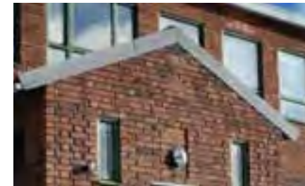
Wedholms kontorsbyggnads fönster och indragna fogar beaktas.
