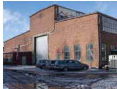
Wedholms maskinverkstad bevaras och omvandlas till skola/förskola. Väster om byggnaden kan stomkonstruktion friställas och bli ett skulpturalt inslag i planerad förskolegård (likt Hermann Blankensteins park i Berlin)
