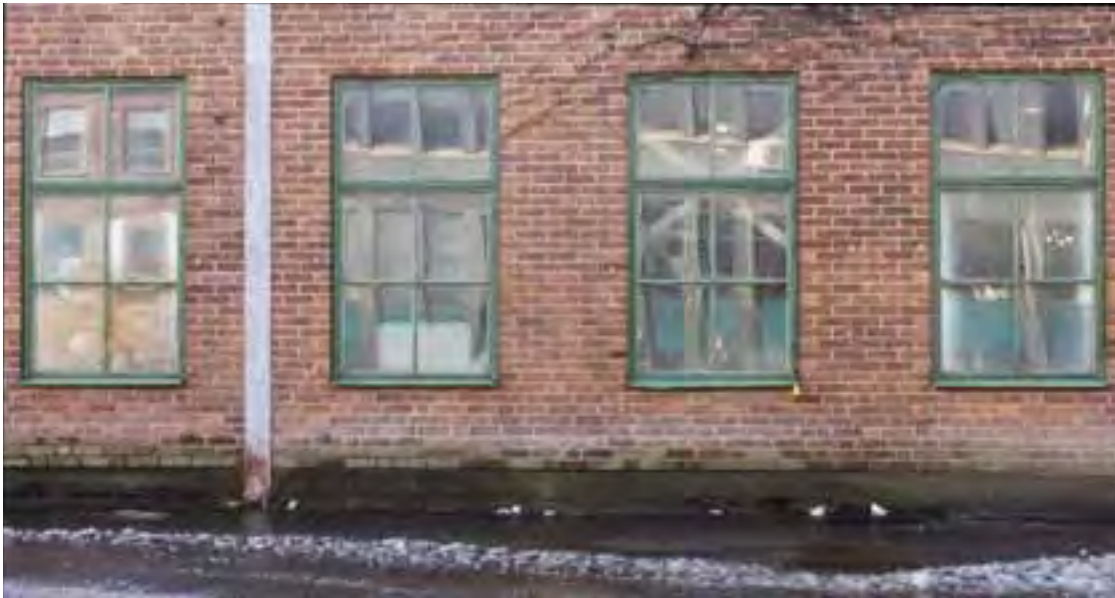
Figur 8-5: Maskinverkstadens östra fasad med ursprungliga spröjsade träfönster. Foto: Mariette Svensson 2017.
