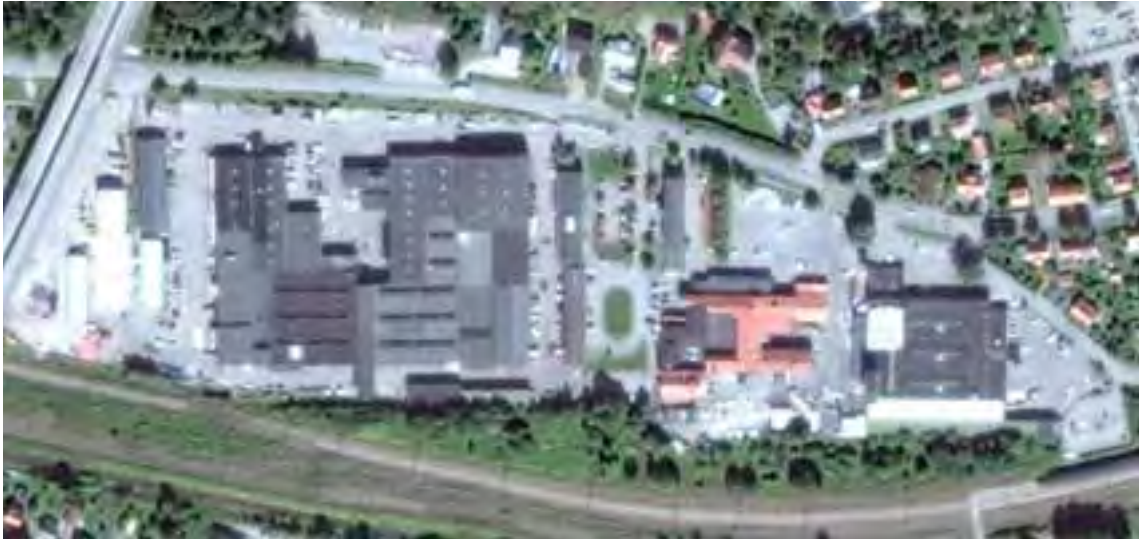
Figur 7-2: Pågående markanvändning av området, med stor industribyggnad och hårdgjorda uppställningsytor.
