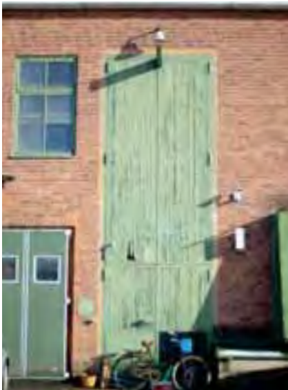
Wedholms västra fasad
