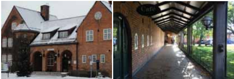
Befintligt stationshus sett från Centralplan samt loggian på stationens västra sida.
