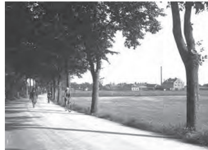
Blommenhovsvägens trädallé återskapas.
