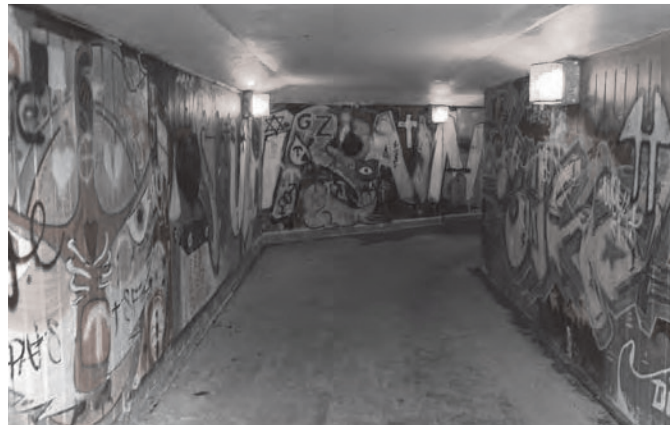
Befintlig koppling under spåren vid stationen planeras att utvecklas vid genomförande av Resecentrum.
