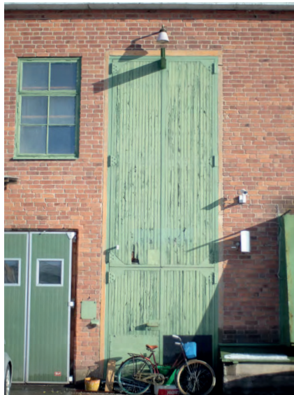
Wedholms västra fasad
