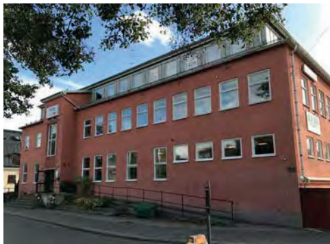
Omvandling verksamhetsbebyggelse. Nyköping
