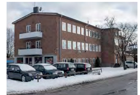
Slakteriets bostads- och kontorshus 3
