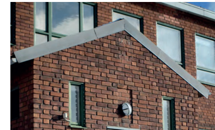
Wedholms kontorsbyggnads fönster och indragna fogar beaktas.
