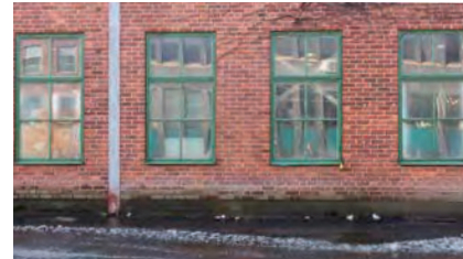
Maskinhallens spröjsade fönster bevaras.
