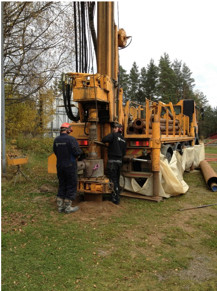
Foto 1. Borrning av brunn.
